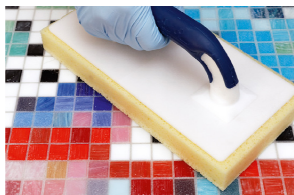
Krémová konzistence – stejná jako u cementových spárovacích hmot. Při nanášení není třeba žádných speciálních nástrojů.
