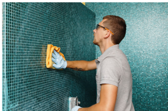
Velmi snadné spárování bez zbytkového povlaku. Stačí setřít čistým hadrem a umýt do čista.
