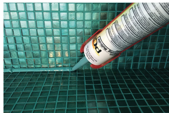
Applikace silikonového tmelu PCI Silcofug® Multicolor v totožném odstínu jako je spárovací hmota PCI Durapox® Premium.
