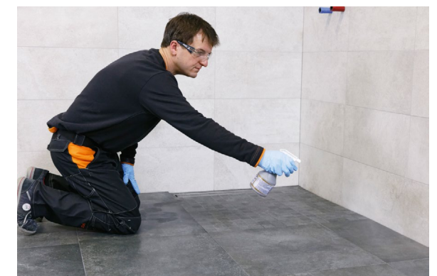
Před konečným umytím povrchu se po cca 60 minutách nastříká na zaspárovaný povrch PCI Durapox® Finish (tekutina v rozprašovači), nebo lze PCI Durapox® Finish (práškový koncentrát) přidat přímo do mycí vody.
