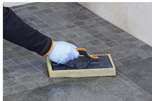
Snadné spárování s použitím epoxidové spárovací hmoty PCI Durapox® Premium. Není zapotřebí žádné speciální nářadí.
