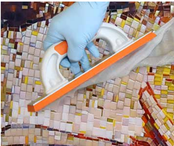
Krémová konzistence – stejná jako u cementových spárovacích hmot. Při nanášení není třeba žádných speciálních nástrojů.
